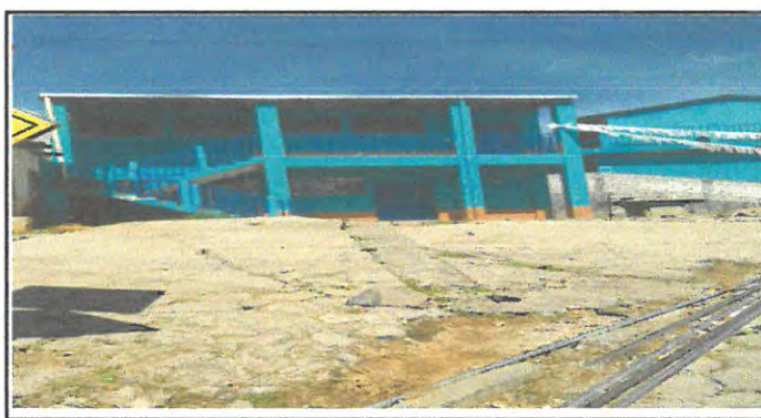
Foto 6: Sustitución de pavimentación de patio
