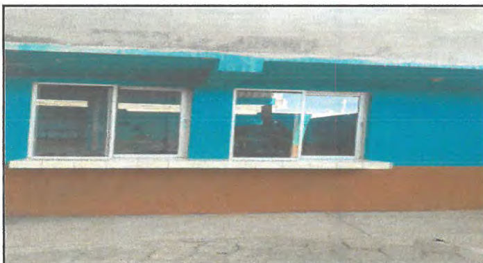
Foto 9: Balcones ventanas de cocina
