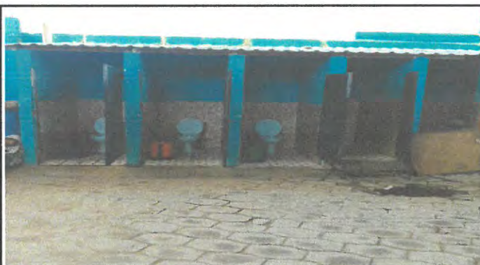
Foto 10: Limpieza de fosa septica sanitarios
