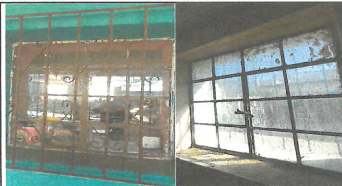
Foto 1: Cambio de ventanas en el modulo 1
