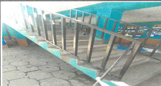
Foto 8: Mantenimiento de barandas
