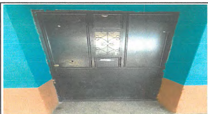
Foto 3: Mantenimiento de puertas de aulas
