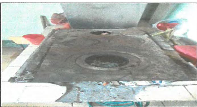
Foto 5: Sustitución de Planca de cocina
