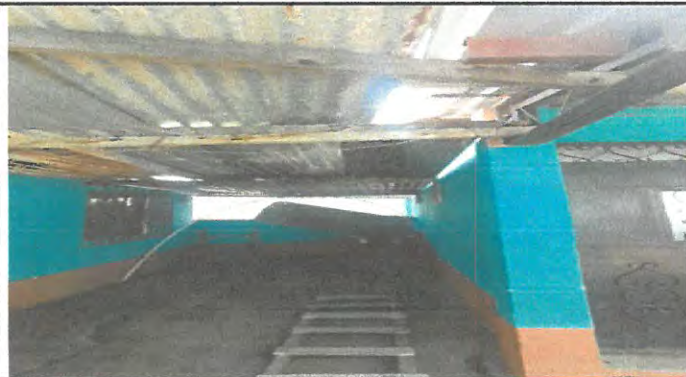
Foto 7: Sustitución de techo
