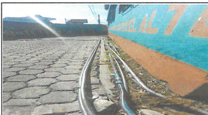
Foto 4: Banqueta en la calle principal
